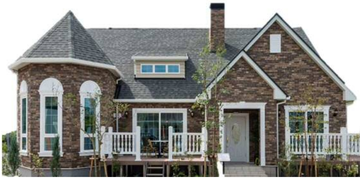
※「エンバカデロ」施工事例
